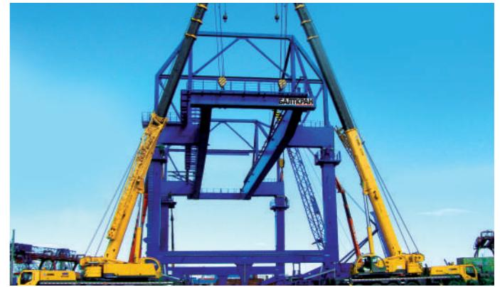
Монтаж козлового крана на рельсовом ходу г/п 45 т.
